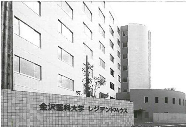
金沢医科大学レジデントハウス外観
