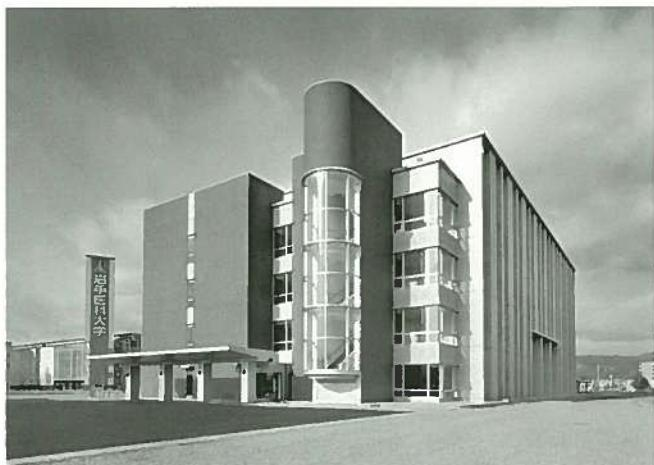
施設外観（延床面積 9,477.8m<sup>2</sup>、RC 造 4 階建、免震構造）
