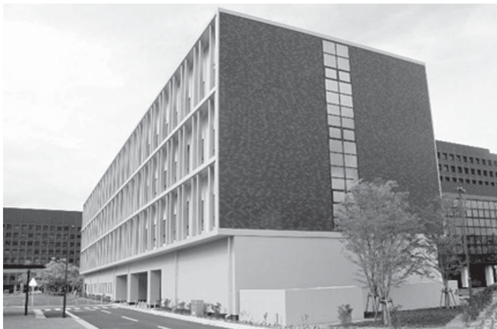
大学病院南別館外観
