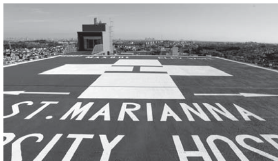
屋上ヘリポート
