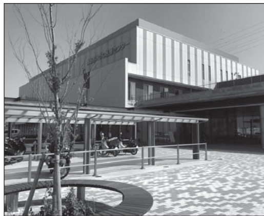
写真4) 香取おみがわ医療センター外観
