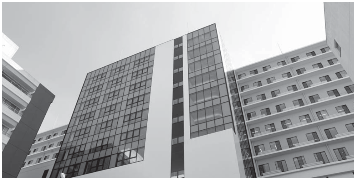
新入院棟外観
